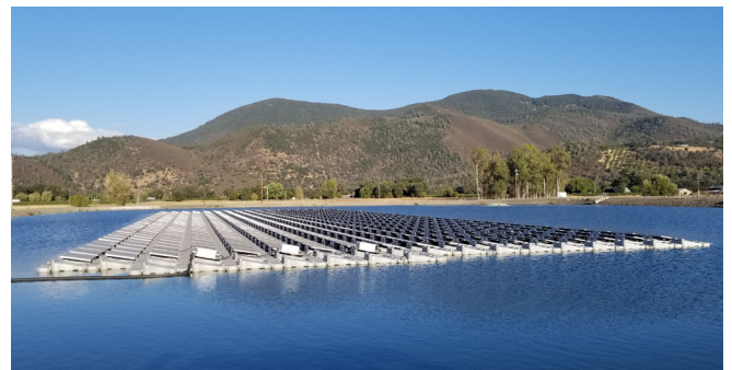
美國 Kelseyville Waterworks 水面型太陽能，252 kW
