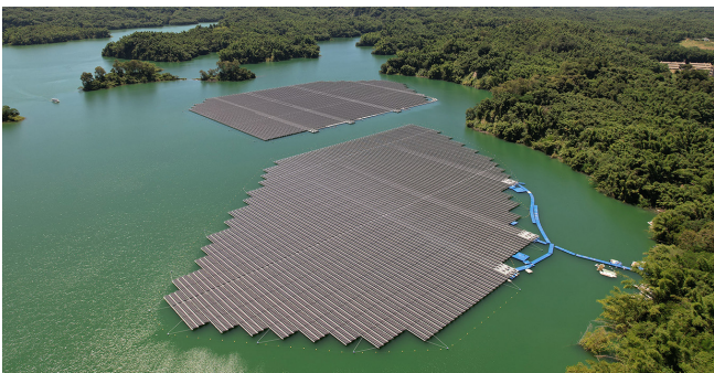
台灣台南烏山頭水庫水面型太陽能，13.7MW
