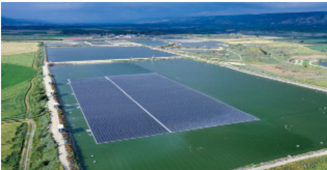
以色列水面型太陽能電廠，7.1 MW
