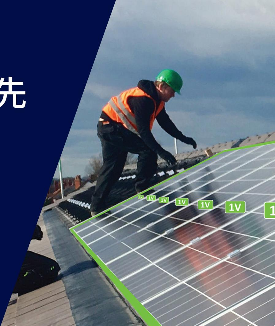
太陽能電廠的設計安全且可靠，全世界裝置的數量已達數百萬場之多。但隨著產業的發展與成熟，加上裝置量持續增加，愈趨嚴格的標準及法規日漸成為常態，如同其他產業一樣。這些標準及法規都指出，在發生火災時，安裝人員、維護人員及消防人員必須要能在交流電切斷時，將直流電降至安全電壓。
