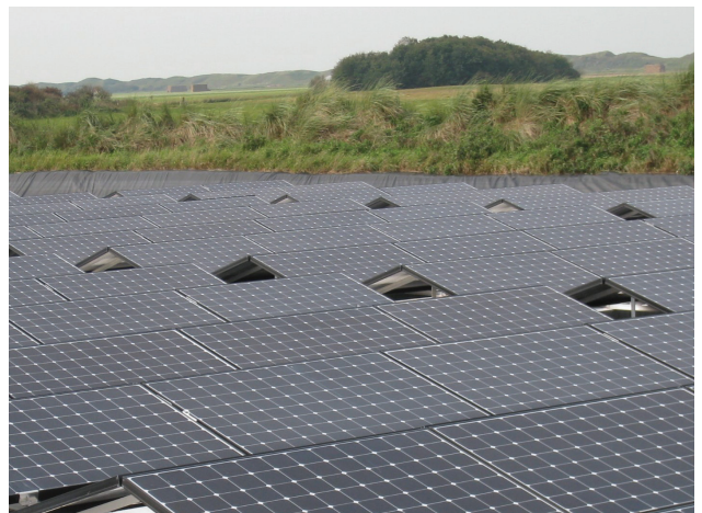
솔라엣지의 설계 유연성은 다른 기울기와 다른 방향에 있는 모듈에서도 에너지 생산을 극대화합니다.
