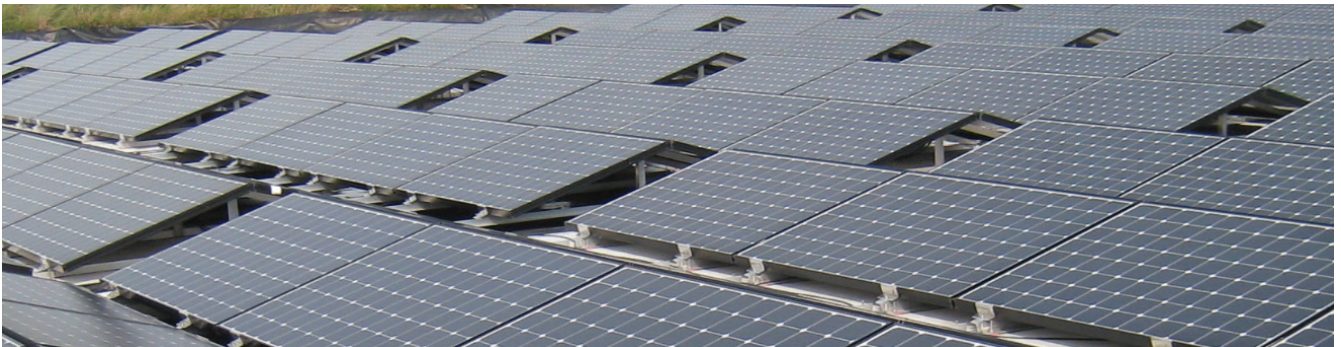
수상 발전소는 수면의 대부분을 덮고 있어서 담수의 증발과 수면에서의 조류의 성장이 감소합니다.
