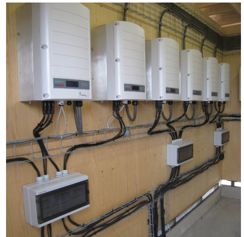
24 x SE27.6K パワーコンディショナが池の隣に設置されています。
