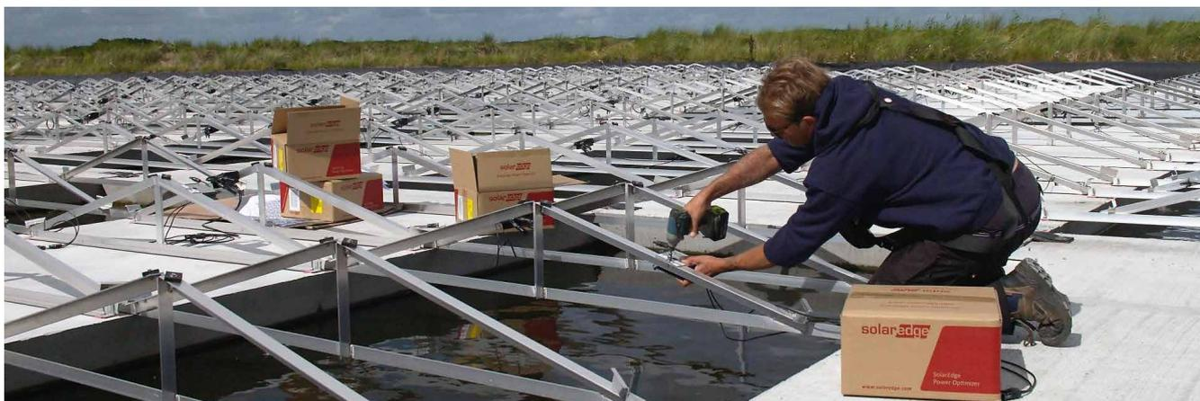
太陽能裝置設置於水庫上方的混凝土浮筒上。
