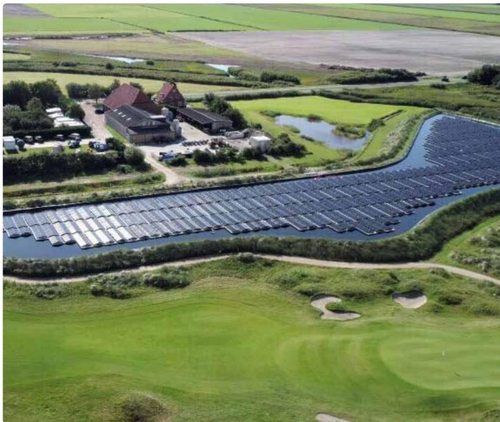
De Krim 渡假村選擇採用創新且具生產力之綠色能源的方案，將浮動式太陽能光電裝置安裝在灌溉高爾夫球場中 7728 平方公尺的雨水水庫內。
