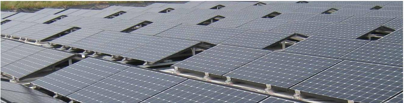
浮動式裝置覆蓋大部分的水面，可減少水面的淡水蒸發量及藻類生長。
