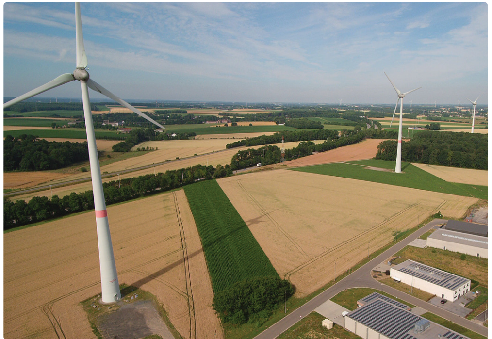
Enersol a choisi SolarEdge pour cette installation afin de minimiser le rendement réduit causé par l'ombrage de l'éolienne située à proximité de l'installation.
