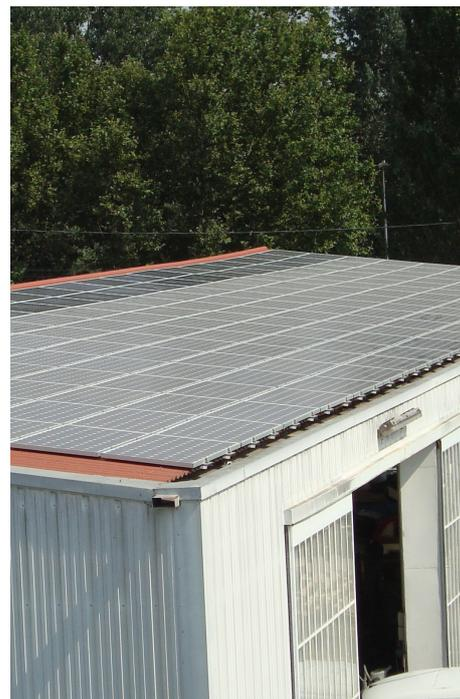
ESV Energie est une société franco-américaine spécialisée dans la mise en œuvre de projets énergétiques rentables en Europe, qui a acquis un système de 34 kW à Tarascon. L'installation se compose de 6 onduleurs SolarEdge SE6000 et de 200 modules Trina Solar de 180 W en silicium monocristallin, équipés d'optimiseurs de puissance de SolarEdge. Il s'agit d'un investissement à long terme.
