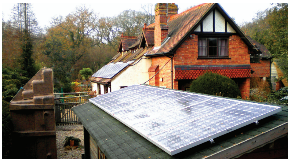
Un impianto da 3,3 kWp, costituito da una stringa con 18 moduli che si estende su due tetti con due pendenze diverse: 25 ° e 40 °. La stringa è collegata ad un inverter SE3300 SolarEdge.
