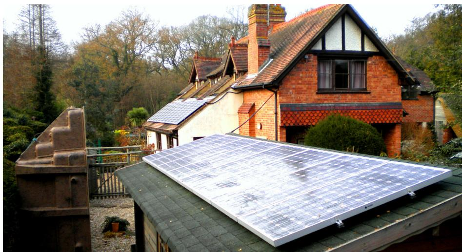
Une installation de 3,3 kWc, avec une chaîne de 18 modules couvrant deux toits de pente différente, 25 et 40 degrés. La chaîne est reliée à un onduleur SolarEdge SE3300.
