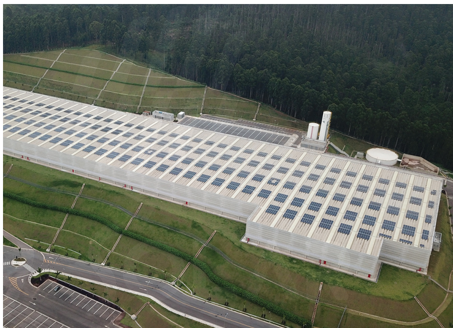
ディーゼル発電機を使用した1.5MW屋根上太陽光発電設置(ブラジル)
