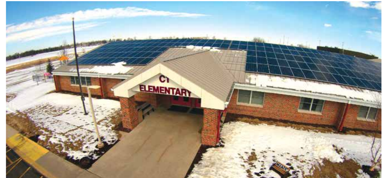
ABD, 756kW Farmington Merkez Okul Binası #265, Illinois
