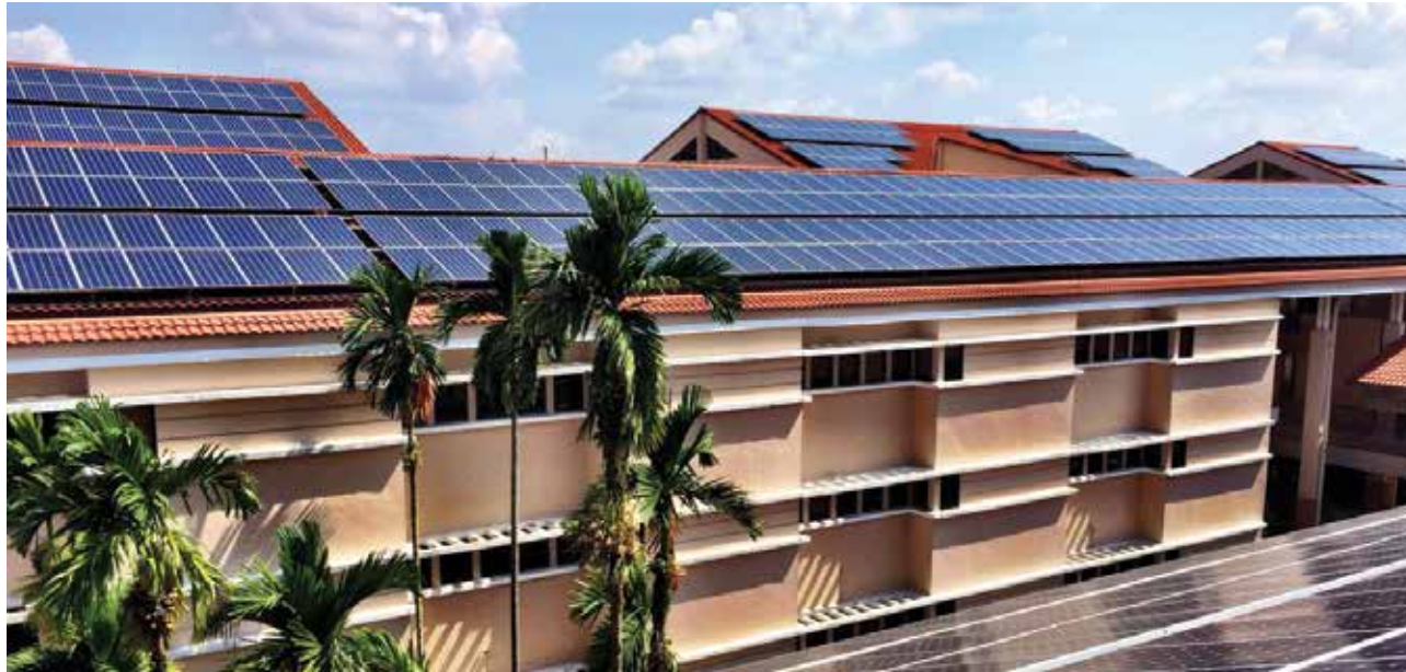
สิงคโปร์ 1MW โรงเรียนอเมริกัน
