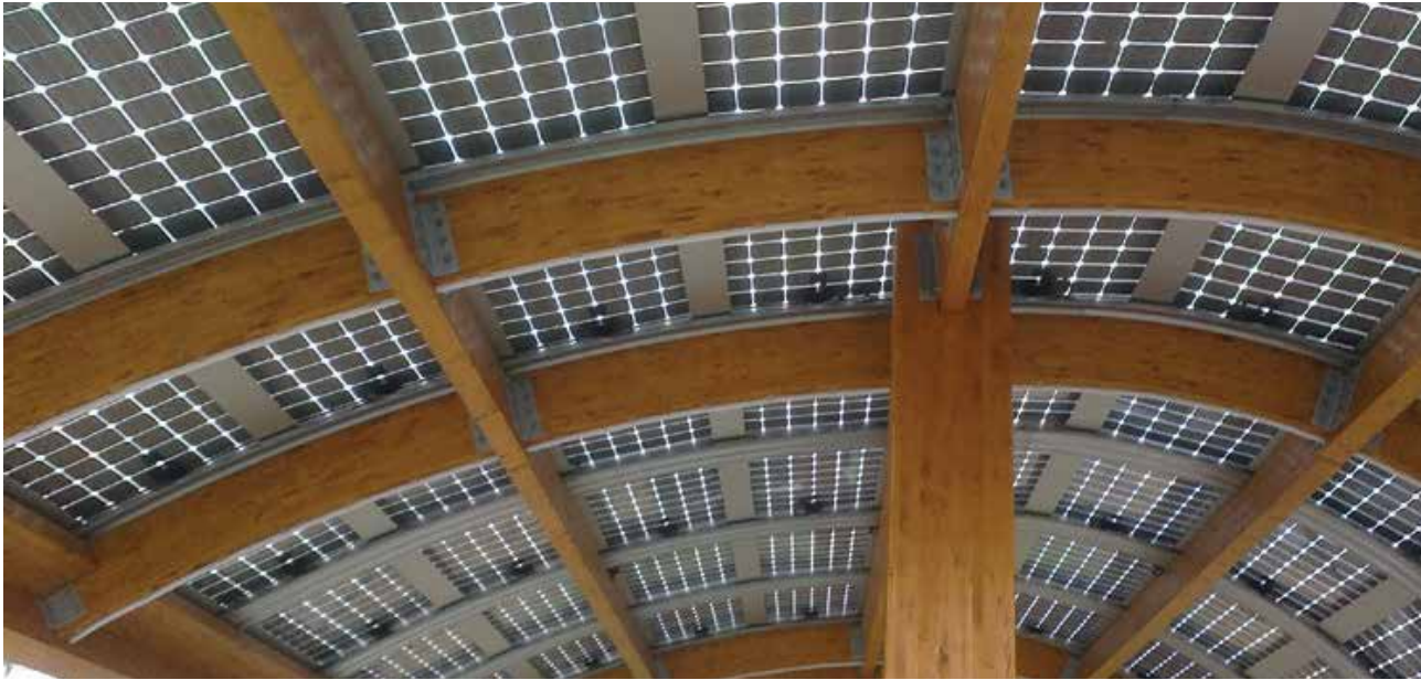
เนเธอร์แลนด์ 3MW สถานีชาร์จรถยนต์ไฟฟ้า 39 แห่ง
