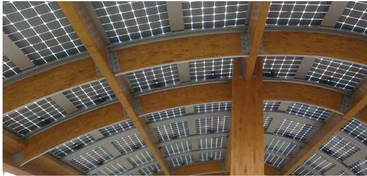
Países Bajos, 3MW 39 estaciones de carga de autos eléctricos
