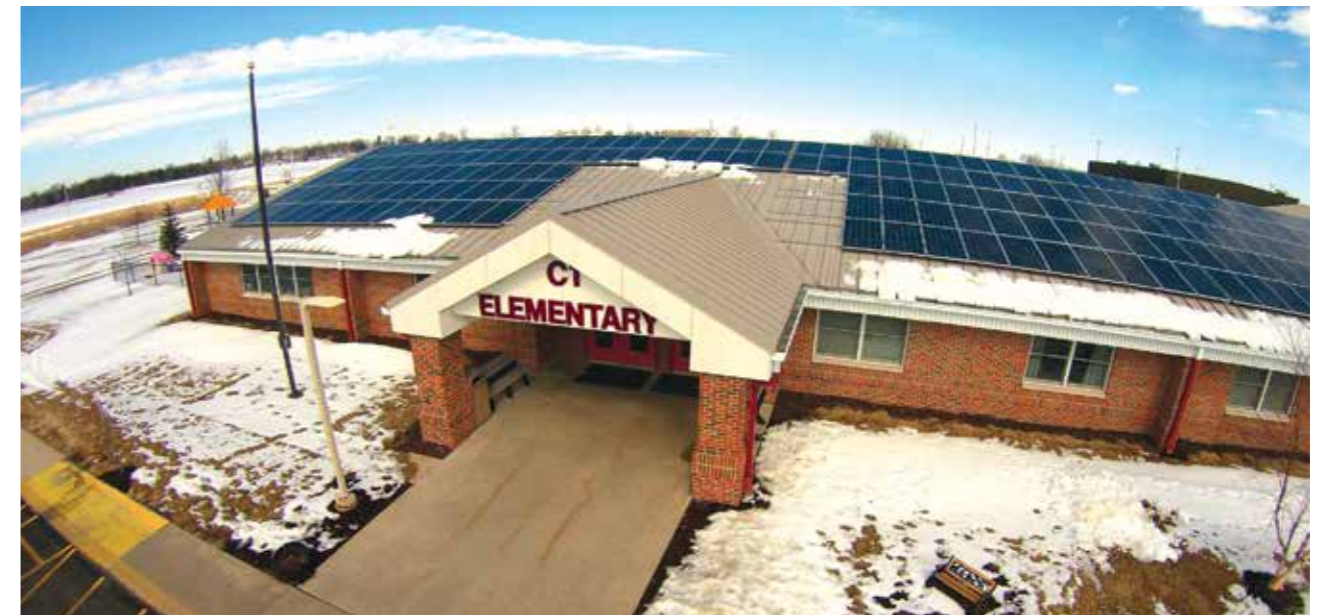
Estados Unidos, 756kW Distrito escolar central 265 en Farmington, Illinois
