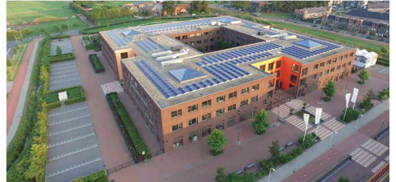
Países Bajos, 303kW De Meerwaarde, en Barneveld
