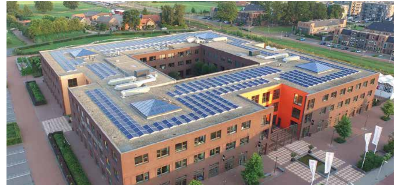
Nederland (303 kW) School De Meerwaarde, Barneveld
