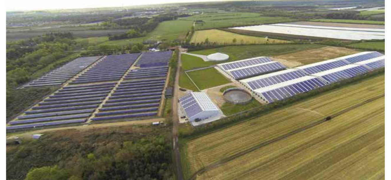
덴마크, 2MW 지상 및 옥상 설치
