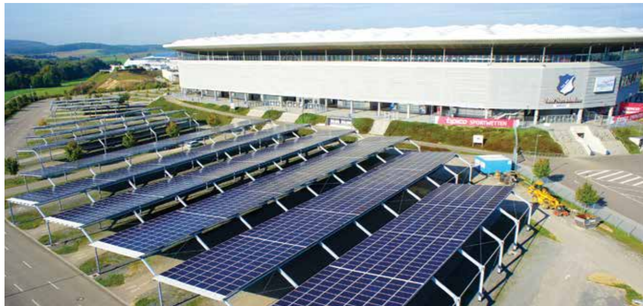
독일, 1MW 진스하임 TSG Hoffenheim 스타디움 간이 차고
