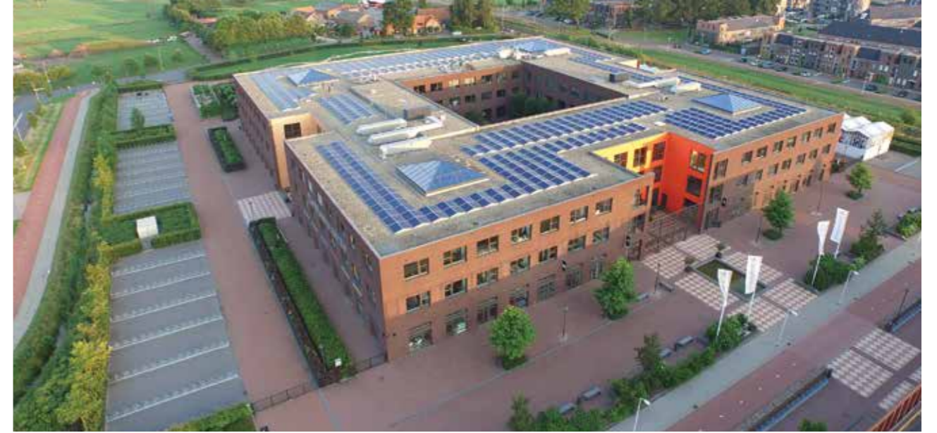
네덜란드, 303kW 바르네벨트, 드 메르바르드
