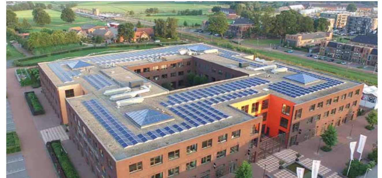
Paesi Bassi, 303 kW Scuola De Meerwaarde, Barneveld
