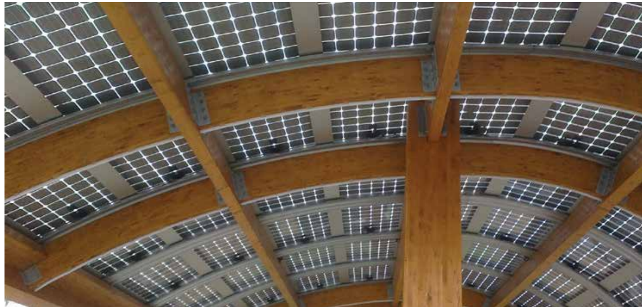
Paesi Bassi, 3 MW 39 stazioni di carica per auto elettriche
