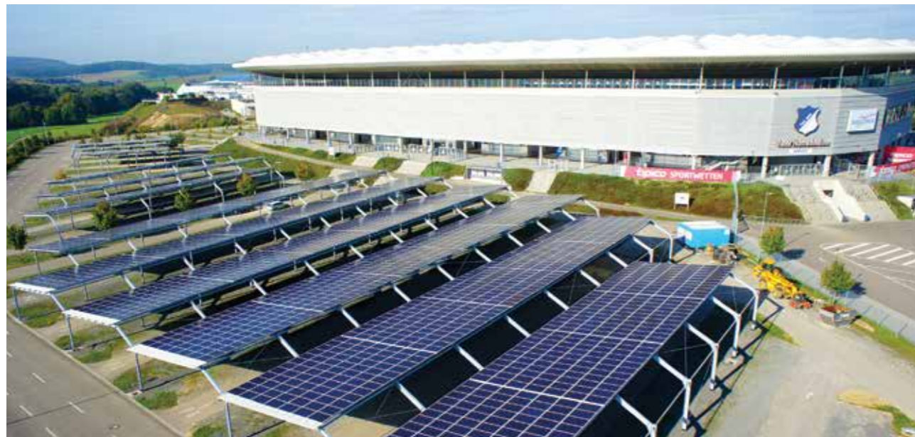
德國, 1MW 辛斯海姆鎮 TSG 賀芬咸體育場的停車場
