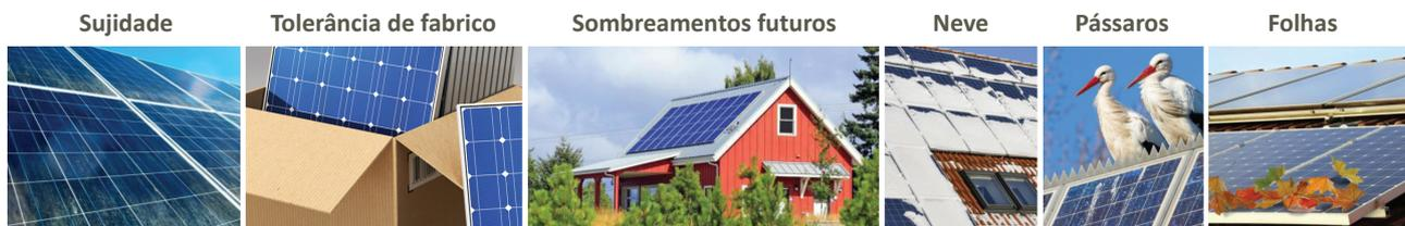
Com os inversores tradicionais, o módulo mais fraco reduz o desempenho de todos os painéis. Com SolarEdge, cada painel produz a máxima energia e as perdas são eliminadas.
