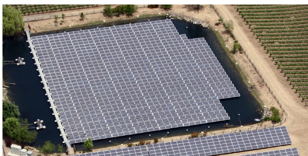
การติดตั้งระบบลอยน้ำของ SolarEdge สหรัฐฯ 386 กิโลวัตต์
