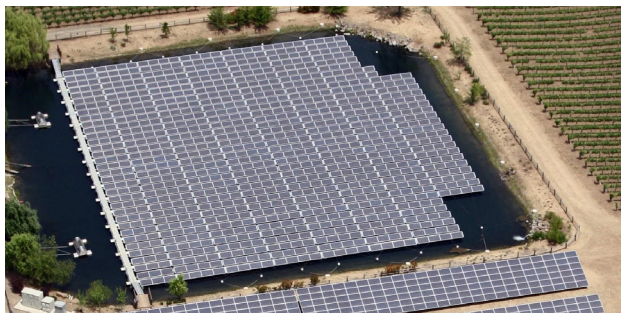
솔라엠티지 부유식 태양광 발전소, 미국, 386 kW
