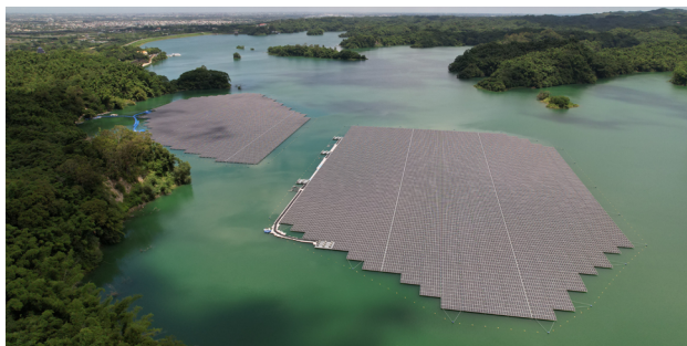
SolarEdge水面型系統，13.7MW，台南烏山頭水庫
