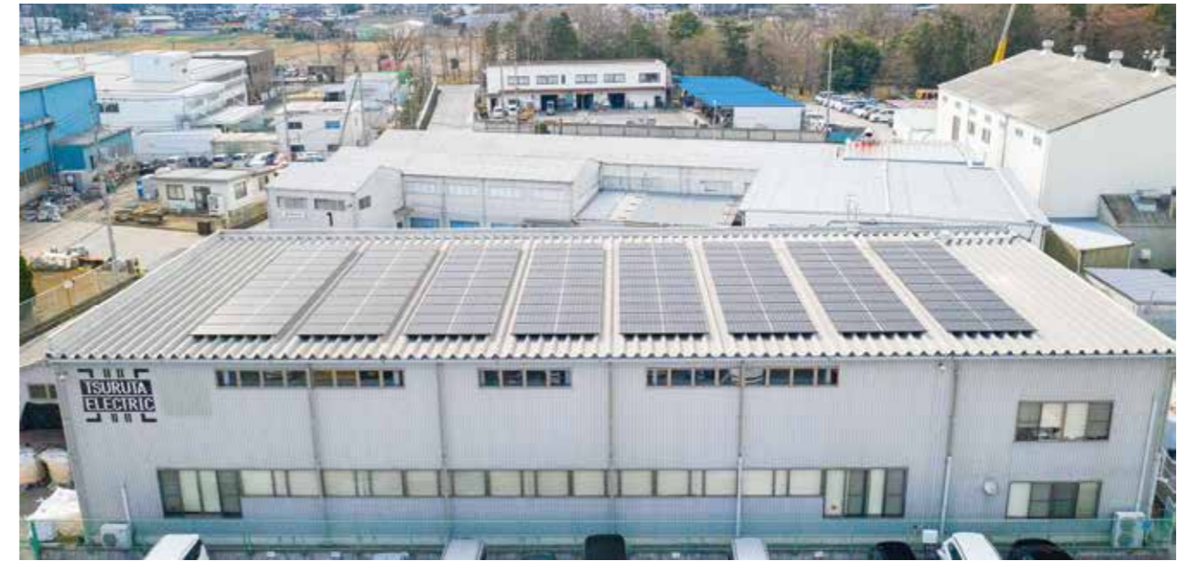
49.5kW ソーラーエッジ自家消費ソリューション SE25K-JP x2台 ソーラーエッジスマートモジュールSPV-300MMJ x176枚
