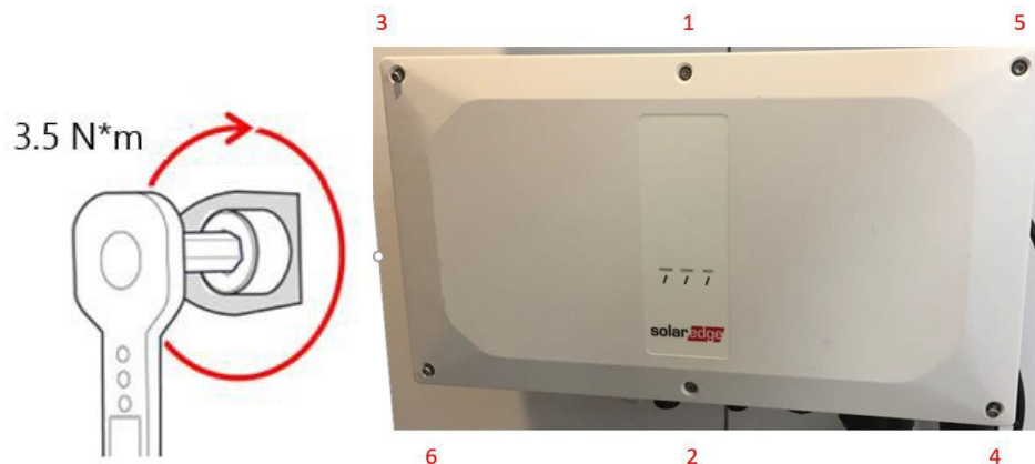
図19：ネジの締め付けの順番
