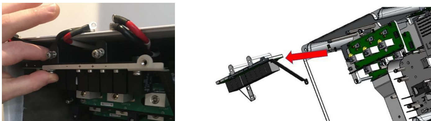
Figura 9: rimuovere il gruppo della sbarra collettore di messa a terra
