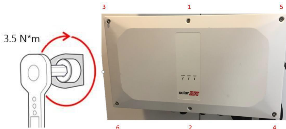
圖 19：螺釘鎖緊順序
