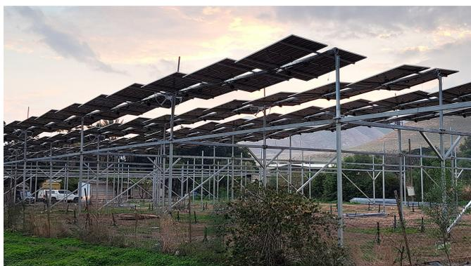
Installazione in altezza con gli inseguitori fotovoltaici SolarEdge
