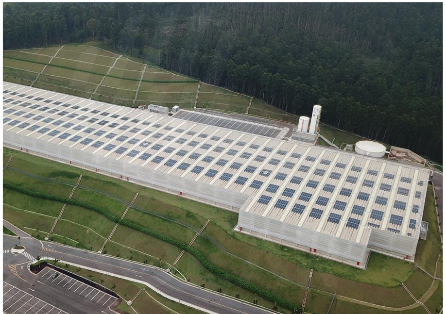
Sistema fotovoltaico sobre cubierta de 1,5 MW con generadores diésel, Brasil (550kVa),
