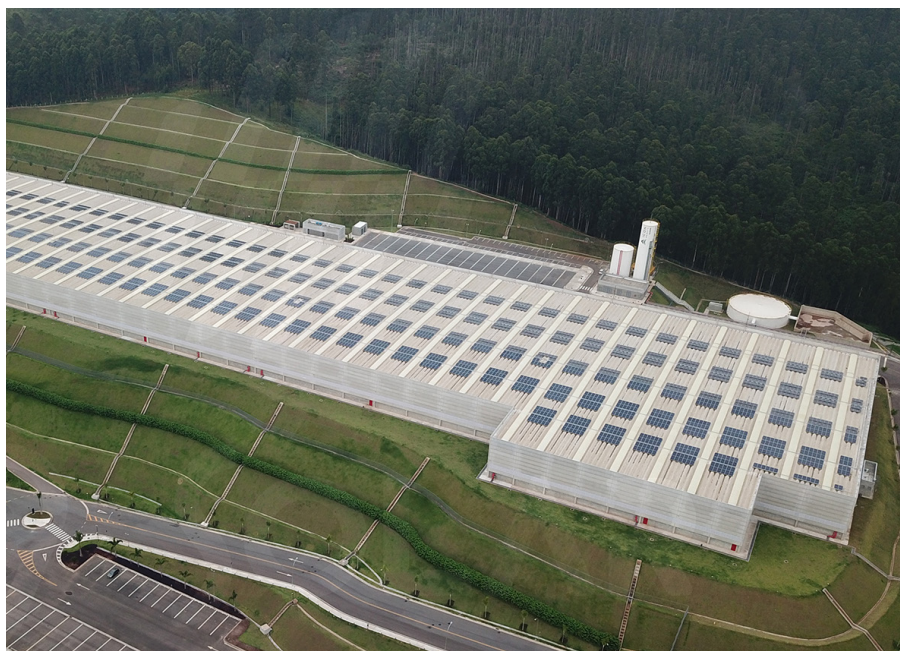
Impianto fotovoltaico su tetto da 1,5 MW con generatori diesel, Brasile (550kVa),
