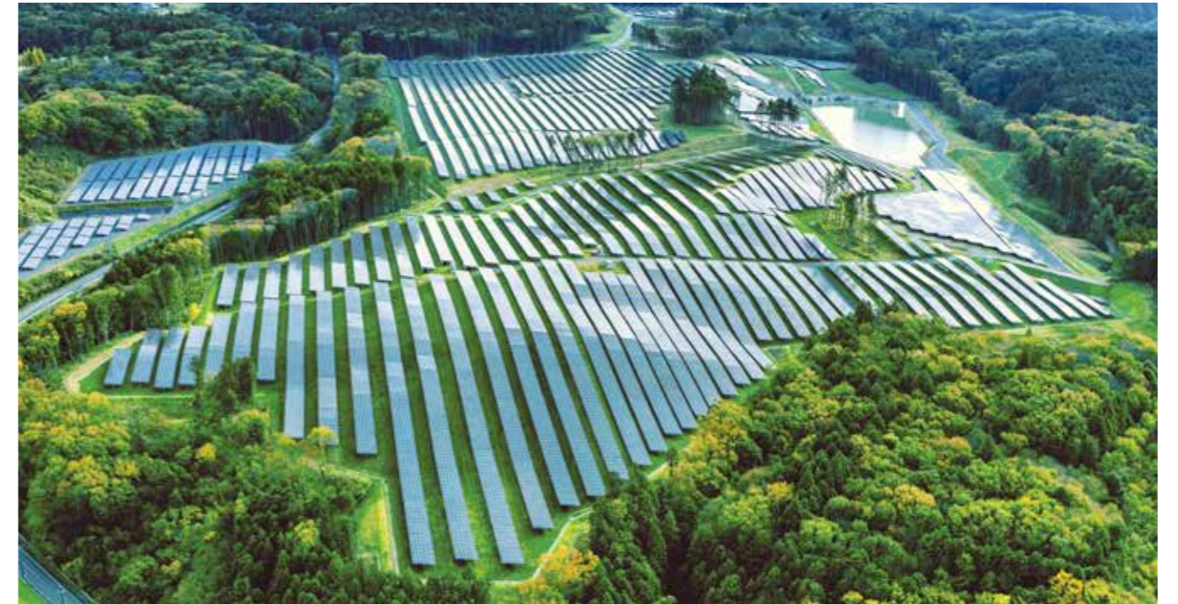
ソーラーエッジソリューションは、モジュールレベルでDC最適化を行うため、ストリング内のモジュールの傾斜角に高い自由度があります。このような起伏の多いサイトでも傾斜角を気にせずに設置することができ、土木コストや架台コストを削減できます。
