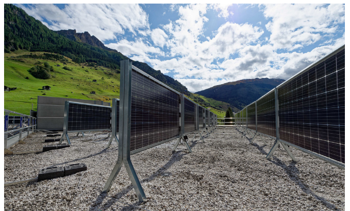
採用SolarEdge技術的垂直模組系統
