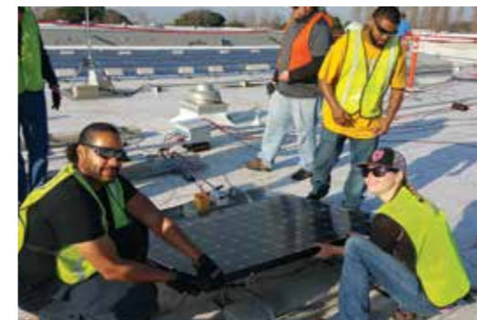
Praca w zespole przy zamianie dachu w instalację fotowoltaiczną
