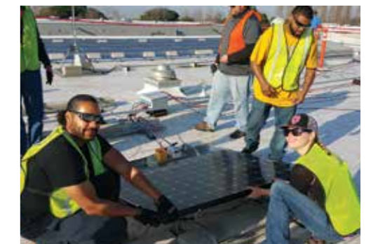
Teamwork voor een dakinstallatie
