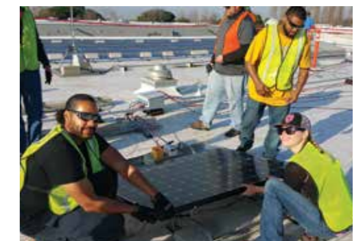
Créer une toiture photovoltaïque : un travail d'équipe
