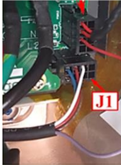
図5パワーコンディショナの信号線の取り外し
