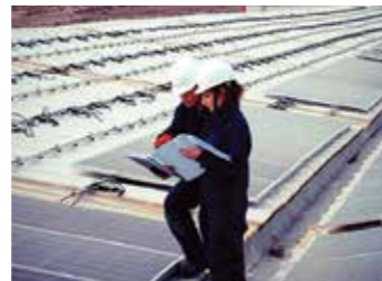
Installatiesupport op afstand en op locatie door onze serviceteams
