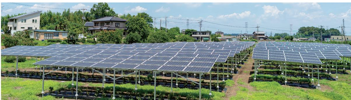
ソーラーシェアリングでは、モジュールが人の視線より大幅に高い場所にあり、目視での点検が出来ません。ソーラーエッジシステムは、モジュール2枚ごとに設置されているパワーオプティマイザにより、モジュールレベルのモニタリングが可能となります。これにより、発電所の健全性を遠隔で詳細に確認することができ、メンテナンス性が大幅に向上します。ソーラーシェアリングの低コストで効率的な資産管理が可能となりました。
