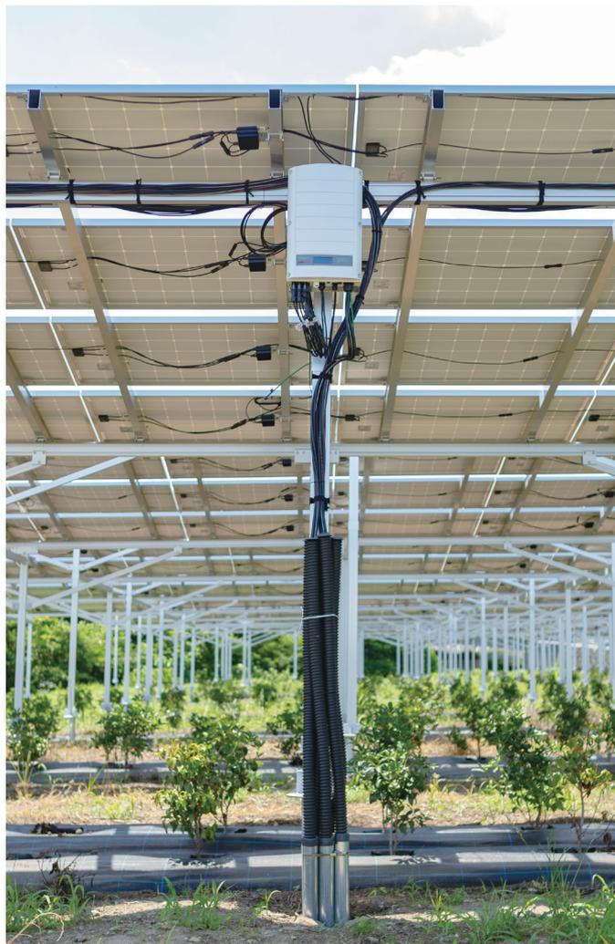
ソーラーエッジシステムは、交流のみならず直流回路で地絡、断線など問題が生じると各パワーオプティマイザの出力は1Vの安全電圧になり、ストリング端の電圧は20-25V程度に抑えられます。アレイ下で人が作業することが前提のソーラーシェアリングにとって、たとえ太陽光発電システムに不具合が生じてても、作業している人々の安全を確保することは非常に重要です。ソーラーエッジの直流安全機能 SafeDC はその高い安全性で農作業を行う人々の安全性を大幅に向上します。
