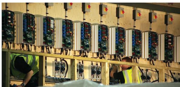
エムパワーエネルギー社は、ソーラーエッジパワーオプティマイザとソーラーエッジパワーコンディショナを組み合わせることで、屋根上でストリングを論理的かつシンメトリックに並べることができるようになり、(このサイトの屋根に)より多くのモジュール搭載が可能となった。
