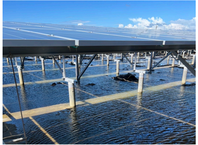
圖 3：台南的太陽能電站由於雨季造成的淹水
