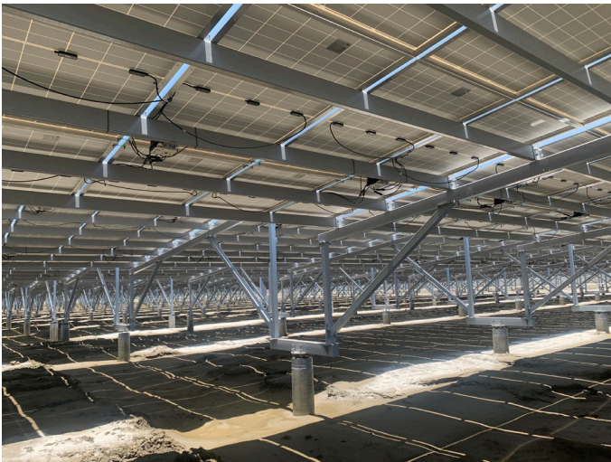
圖 4：SolarEdge 功率優化器連接太陽能模組，優化系統的發電
