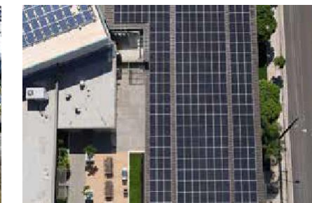
倉庫・データセンター
